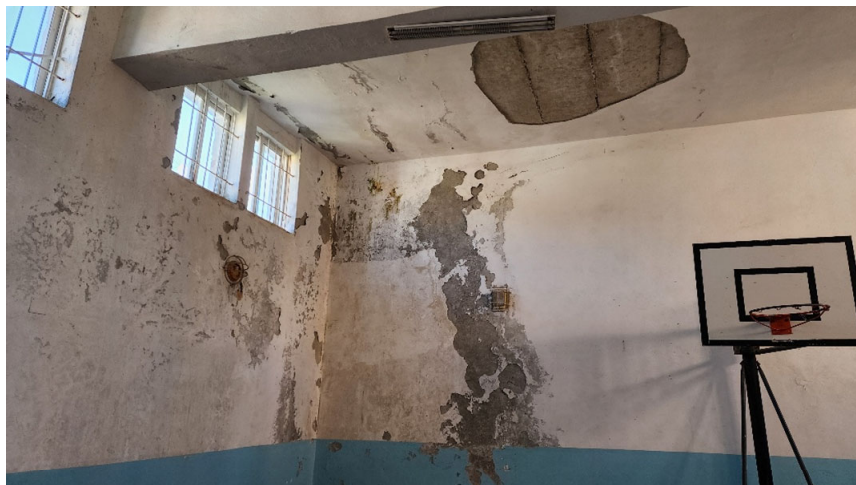
Fig. 5: Foto te gjendjes egzistuese
