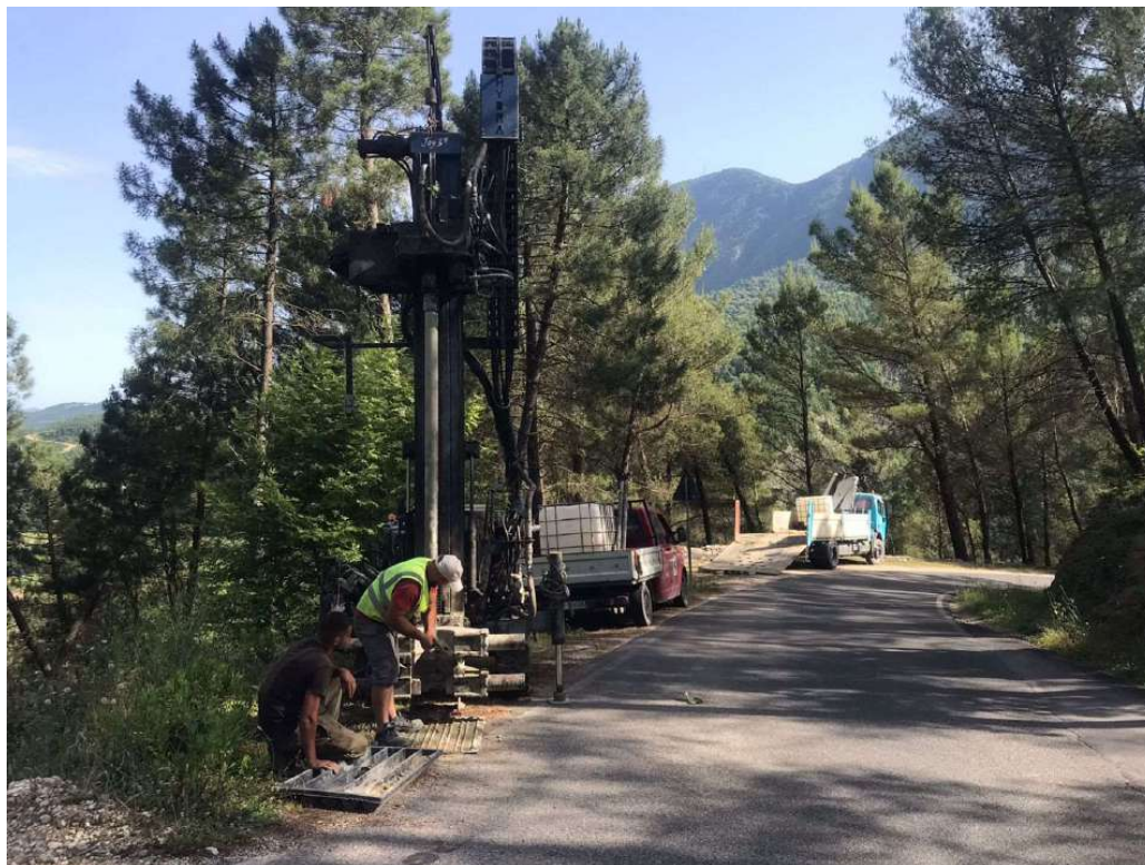
Foto 9. Foto gjatë kryerjes së shpimit BH 3
