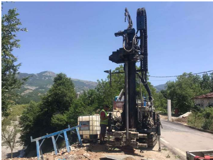
Foto 4. Foto gjatë kryerjes së shpimit BH 1
