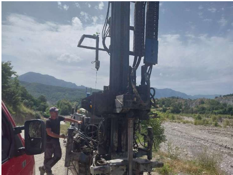
Foto 6. Foto gjatë kryerjes së shpimit BH 2
