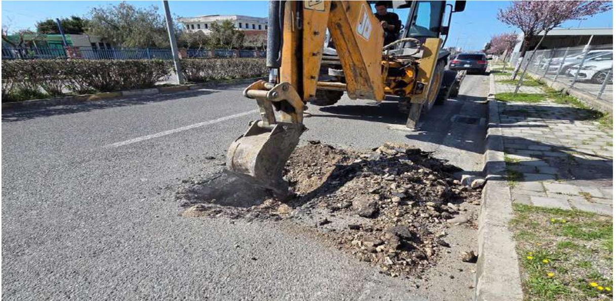
3-Foto gjate hapjes se gropes se kontrollit nr. 2
