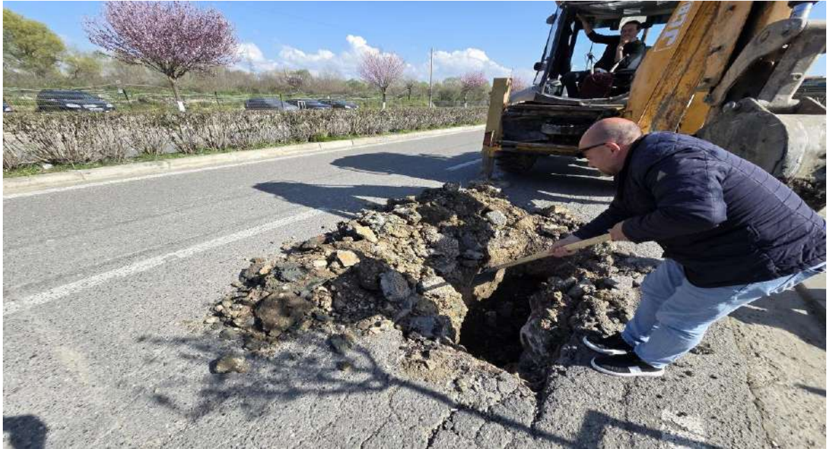
7-Foto gjate hapjes se gropes se kontrollit nr. 4
