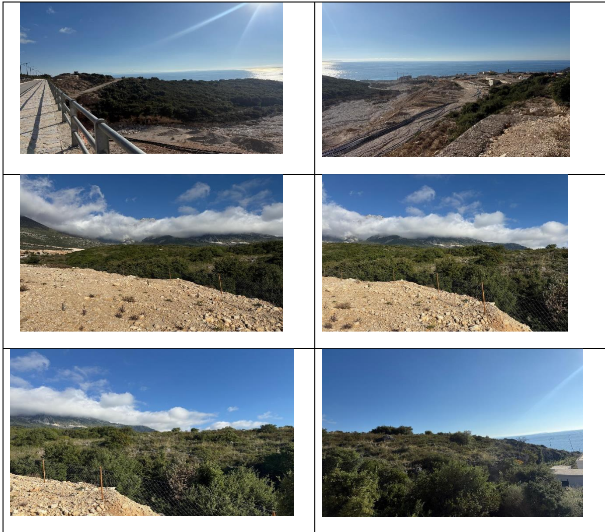
Figura 2: Foto-Gjendja ekzistuese e segmentit rrugor
