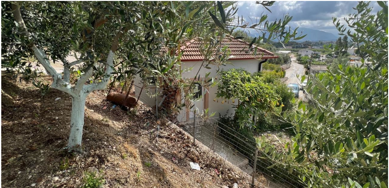
Fig. 7 – Foto të gjendjes ekzistuese
