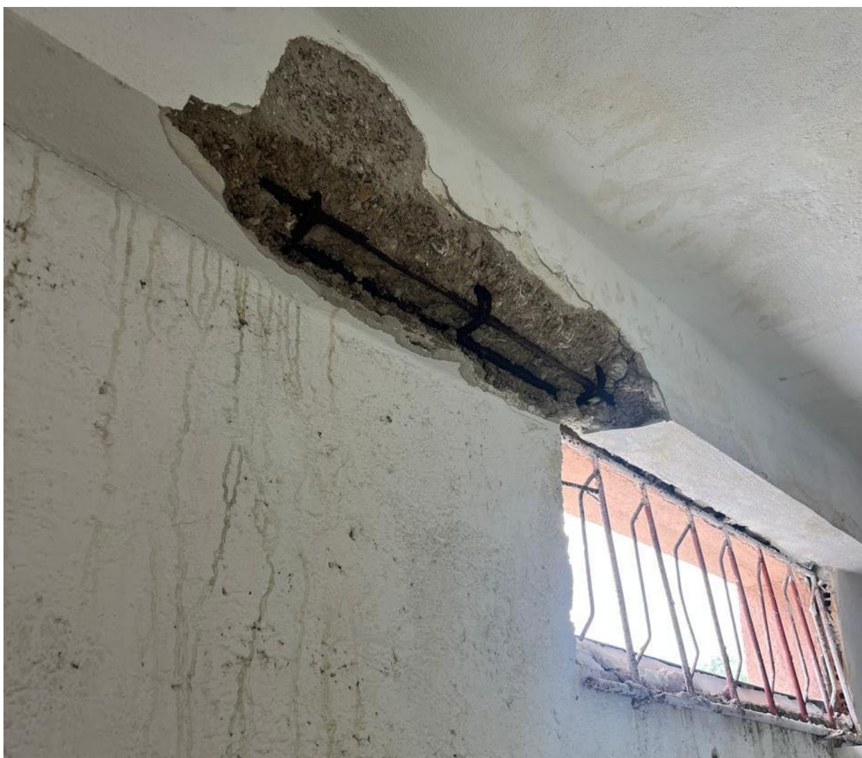
Fig. 6 – Foto të gjendjes ekzistuese
