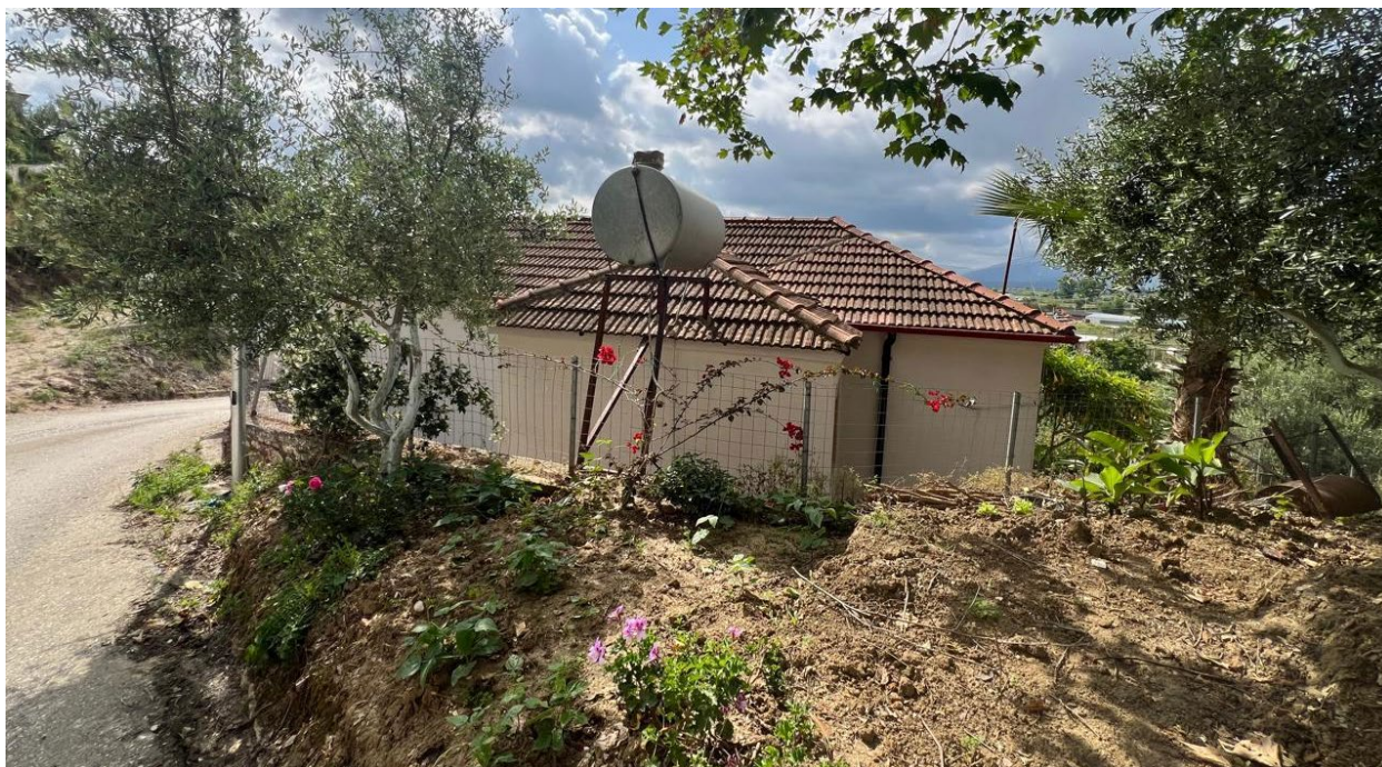
Fig. 5 – Foto të gjendjes ekzistuese
