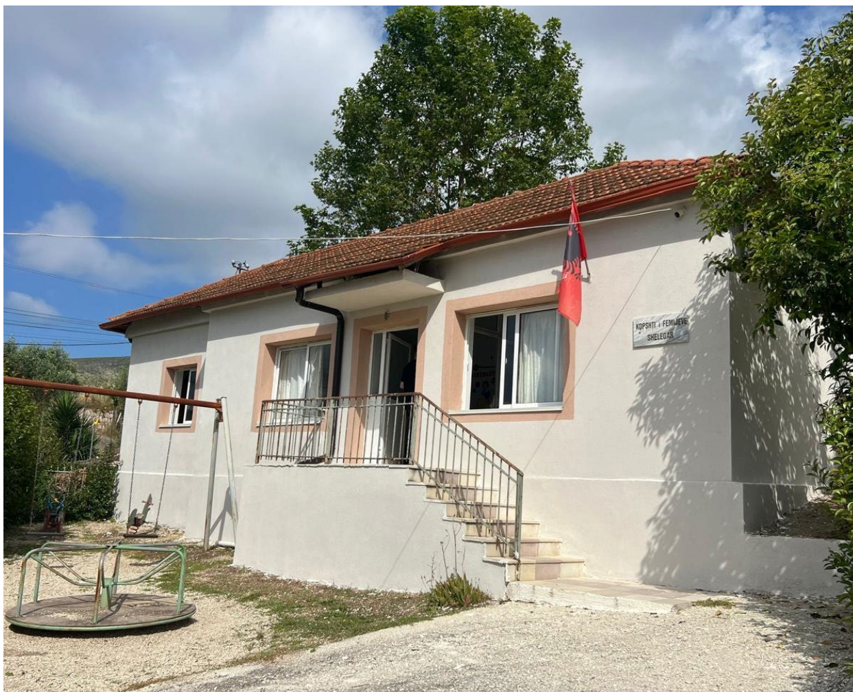
Fig. 4 – Foto të gjendjes ekzistuese
