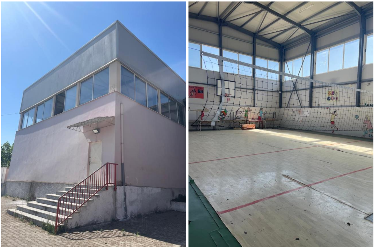
Figura 2. Gjendja ekzistuese e palestrës
