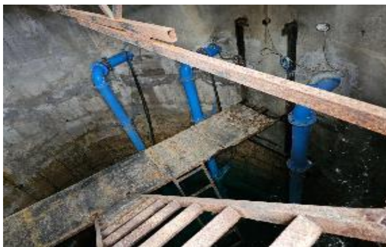
Figura 4: Pompat zhytëse në stacionin e ri Mengel.
