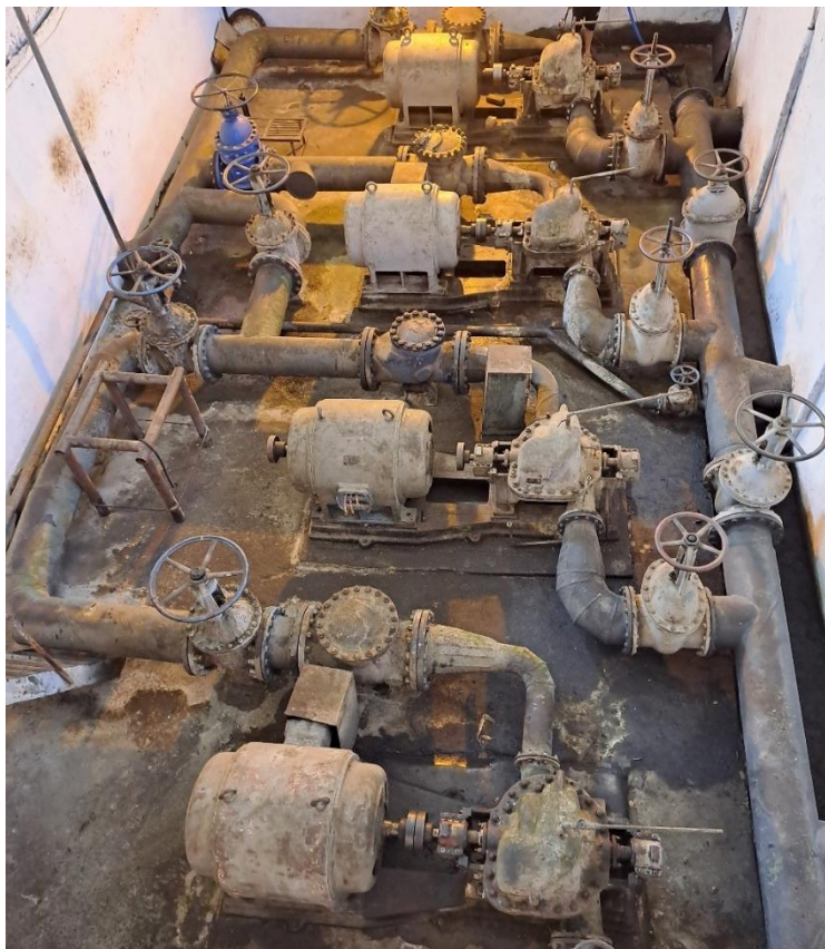
Figura 5: Pompat në stacionin e vjetër Mengel.
