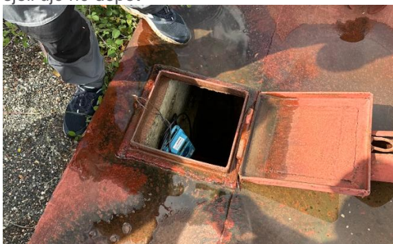
Figura 28: Matja e prurjes në tubin kryesor që sjell ujë në depot
