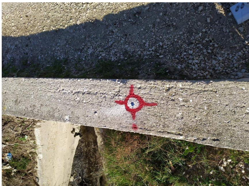
Fig.31 (Pike e Bazamentit Gjeodezik )
