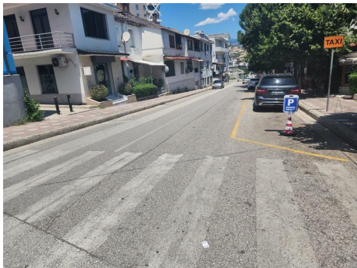
Figura 6. konstatohet një shtresë asfaltbetoni me konsumim të përgjithshëm sipërfaqësor.
