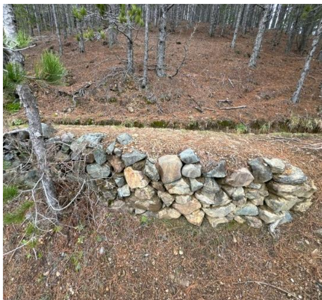
Fig.10 Vija ekzistuese e mbrojtur me strukturë guri në të thatë. Për fshatin dhe qytetin Fushë Arrëz
