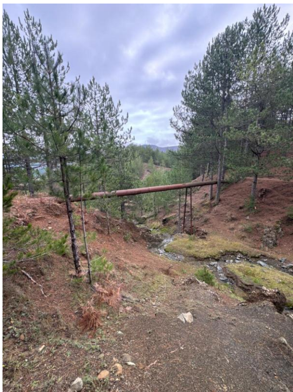
Fig.11 Kalimi i vijës eksistuese të fshatit dhe qytetit Fushë Arrëz me tub hekuri në lartësi, në afërsi të përroit të Micojt.
