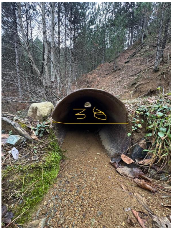
Fig.12 Kalimi i vijës eksistuese të fshatit dhe qytetit Fushë Arrëz me tub metalik në tokë, në afërsi të përroit të Micojt.
