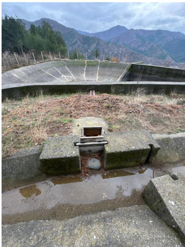
Fig.9 Kanali ekzistues që lidh vijën e vaditjes me rezervuarin në fshatin Fushë Arrëz.
