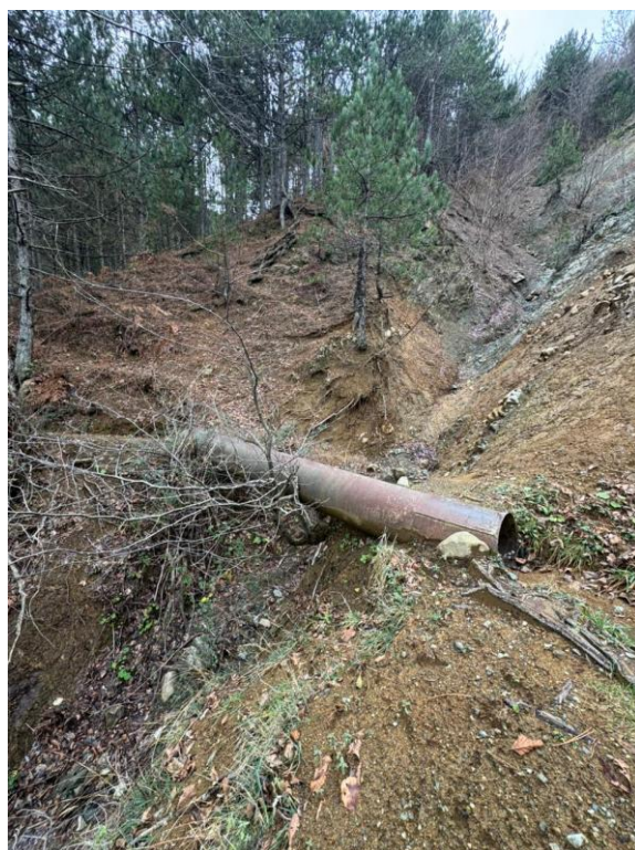
Fig.12 Kalimi i vijës eksistuese të fshatit dhe qytetit Fushë Arrëz me tub metalik në tokë, në afërsi të përroit të Micojt.
