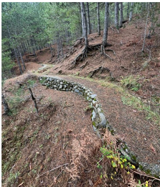
Fig.10 Vija ekzistuese e mbrojtur me strukturë guri në të thatë. Për fshatin dhe qytetin Fushë Arrëz
