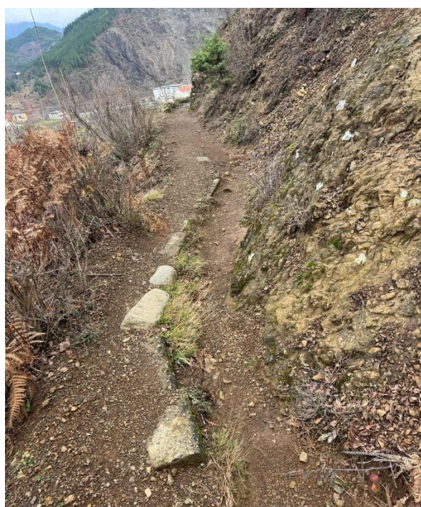
Fig.2 Gjurma e vijës ekzistuese prej dheu pa veshje
