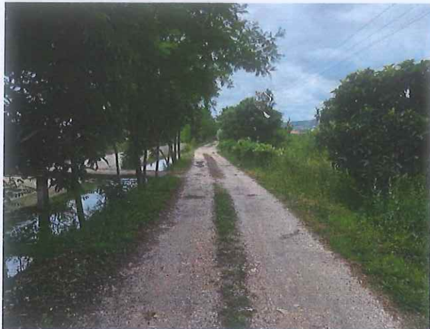
Foto te gjendjes ekzistuese.
