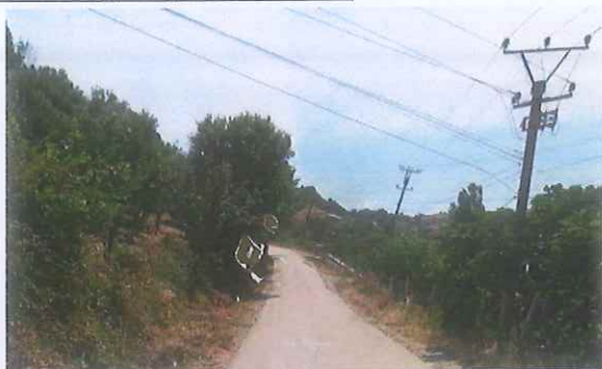
Foto te gjendjes ekzistuese.
