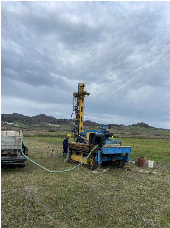
Foto nr.1 Pozicioni i sondes gjate kryerjes se shpimit BH-1
