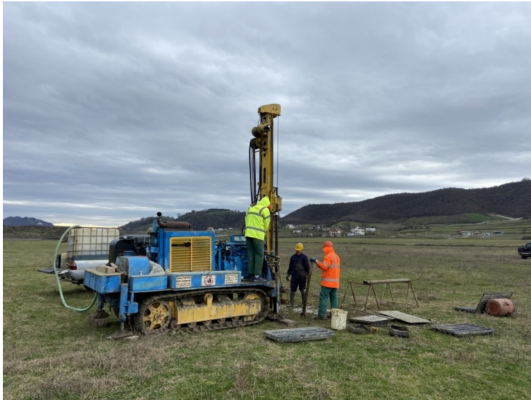
Foto nr.1 Pozicioni i sondes gjate kryerjes se shpimit BH-2
