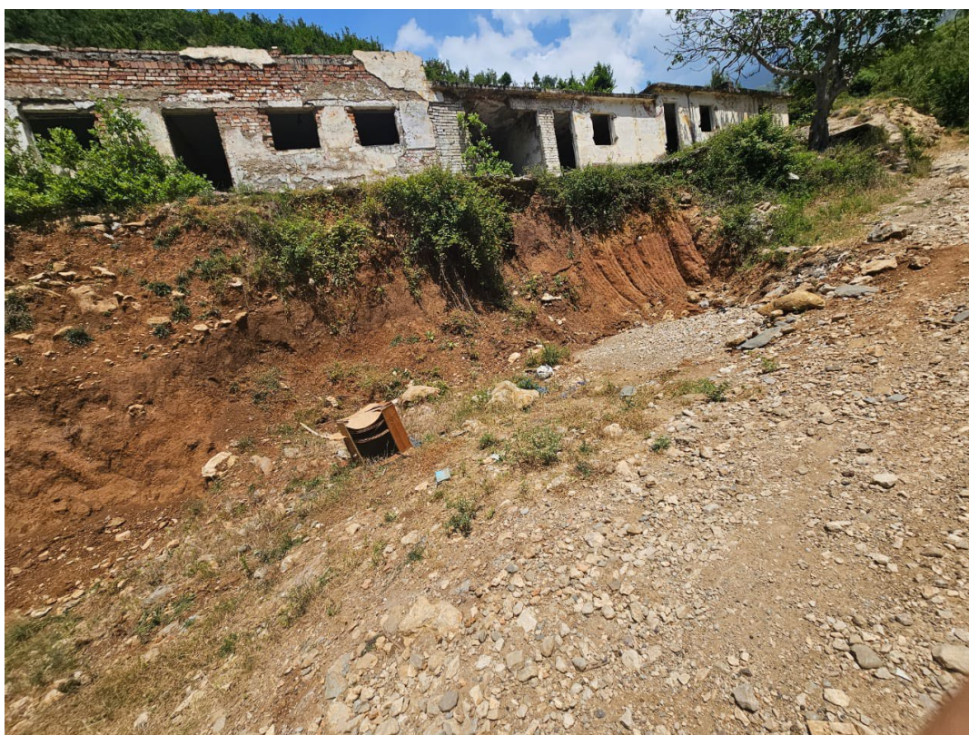
Figure 11 Germime te skarpates poshte objektit qe kane nevoje per mbrojtje ne prog 0+200
