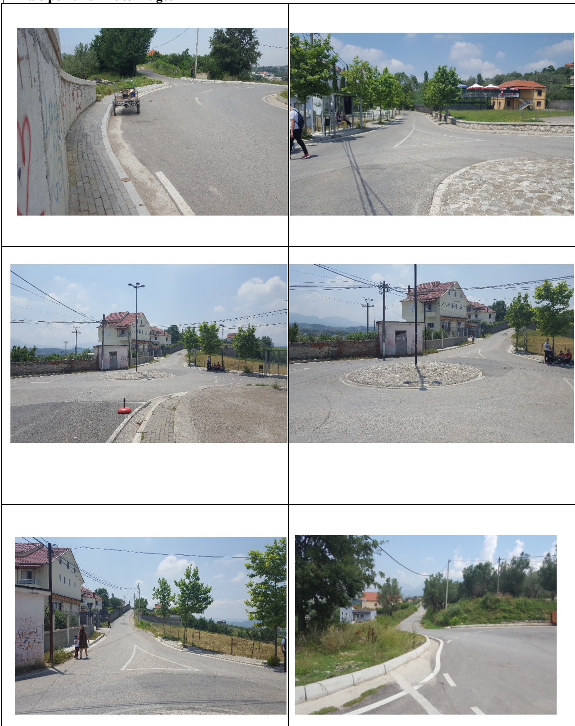
Figura 1 – Foto te rrugës ekzistuese
