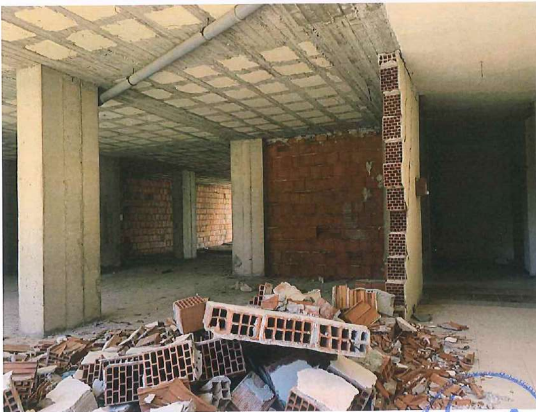
Foto 14. Demitime te renda deri ne renie te mureve perimetral te objektit.
