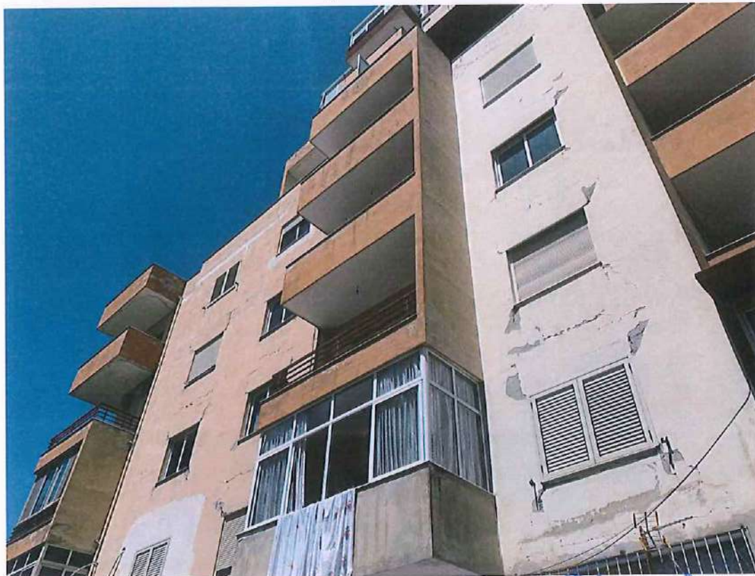
Foto 11. Demtime ne muret perimetral te objektit.
