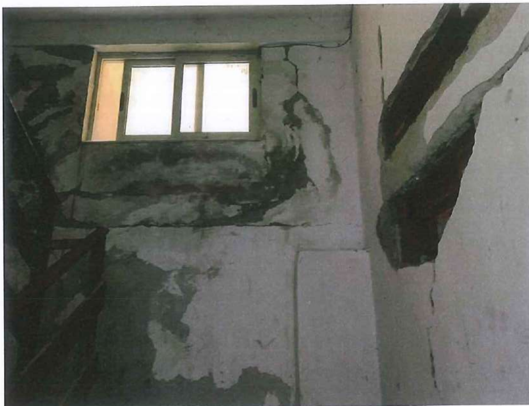
Foto 12. Demtime ne muret e kafazit te shkalleve te objektit.
