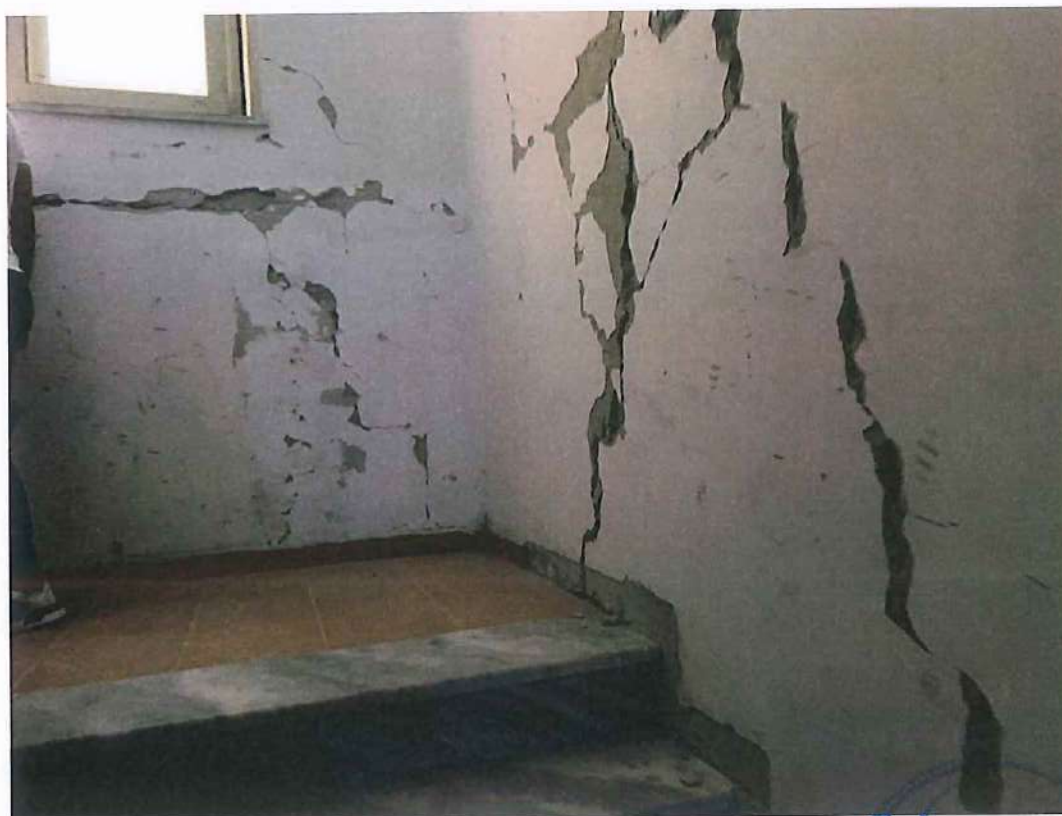
Foto 13. Demtime ne muret e kafazit te shkalleve te objektit.
