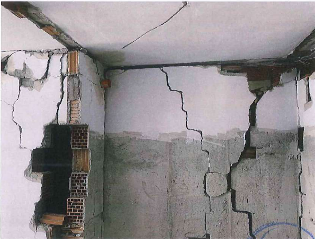
Foto 16. Demtime ne muret e kafazit te shkalleve te objektit.
