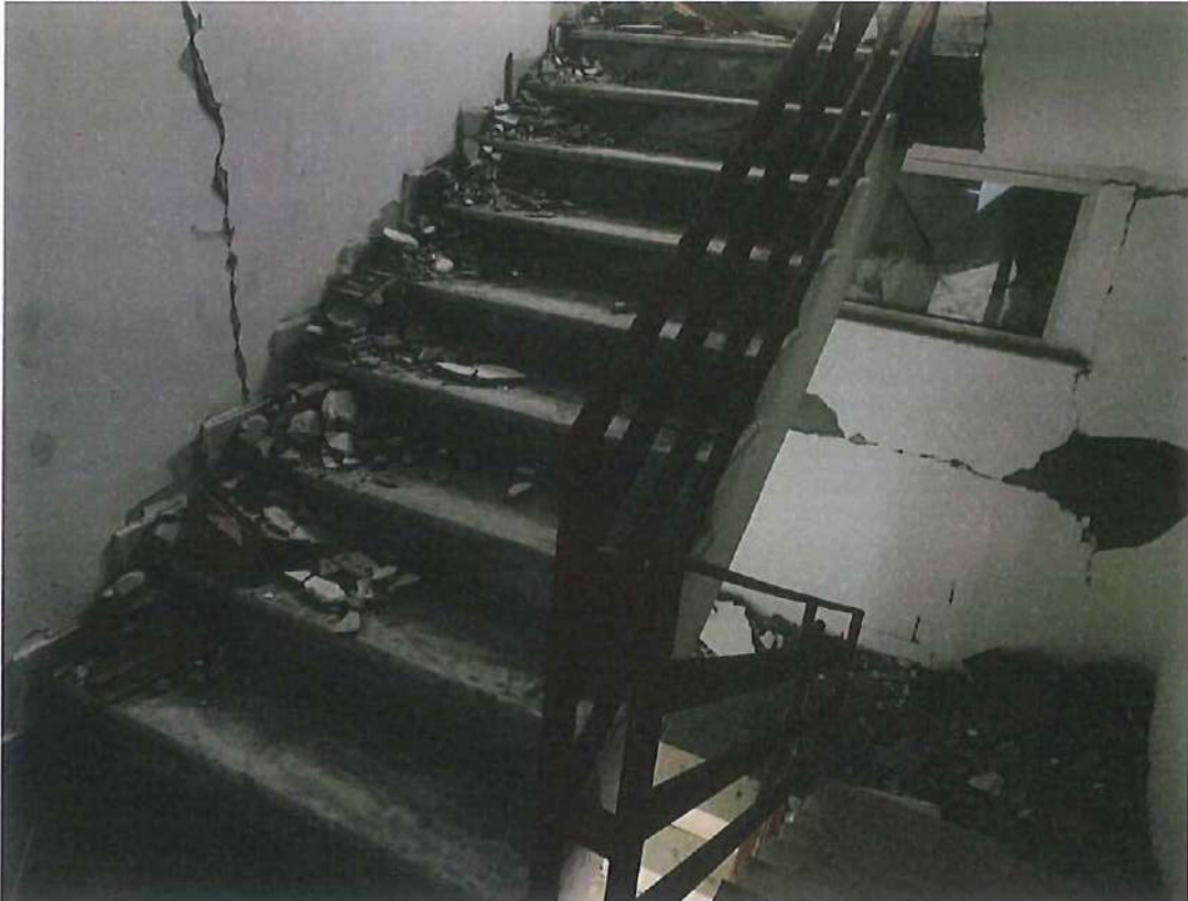
Foto 16. Demtime ne muret e kafazit te shkalleve te objektit.
