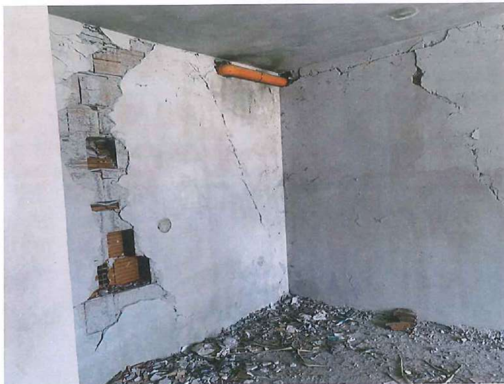
Foto 8. Demtime ne muraturen e objektit.
