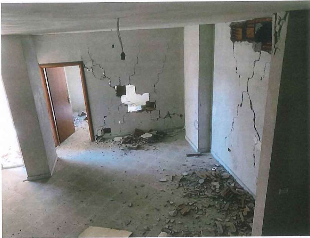
Foto 6. Demtime ne muraturen e objektit.
