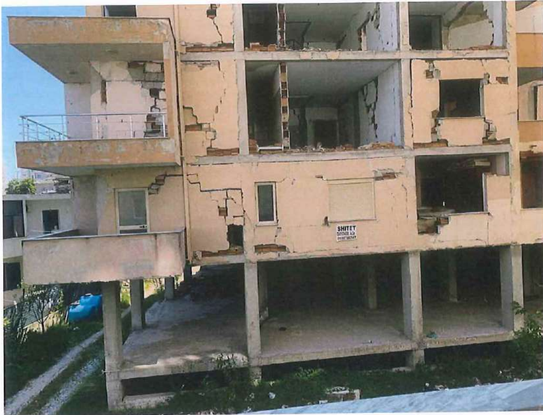
Foto 20. Demtime te renda deri ne renie te mureve perimetral te objektit.
