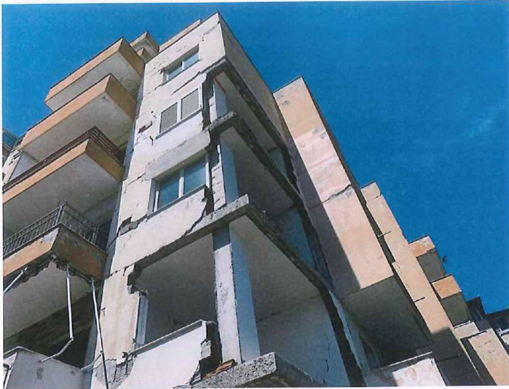
Foto 14. Demitime te renda deri ne renie te mureve perimetral te objektit.
