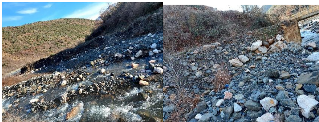
Foto te gjendjes ekzistuese
