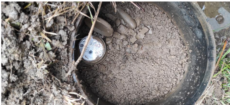
Figura 31: Pamje e ujmatesit dhe saracineskes ne brendesi te pusetes
