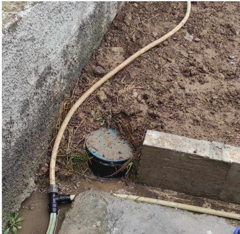
Figura 30: Pusetat plastike prane nje basene ne fshatin Majtare
