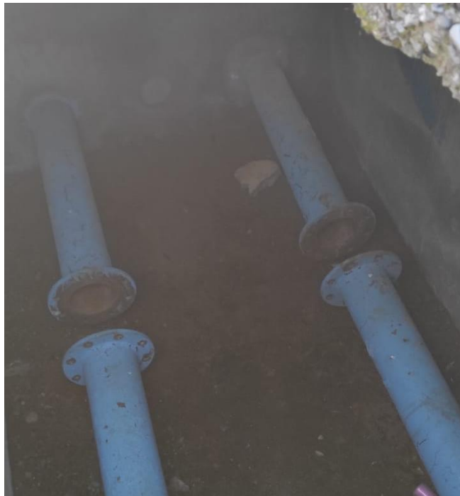
Figura 6: Detaj puseta manovrimi ne hyrje te rezervuarit
