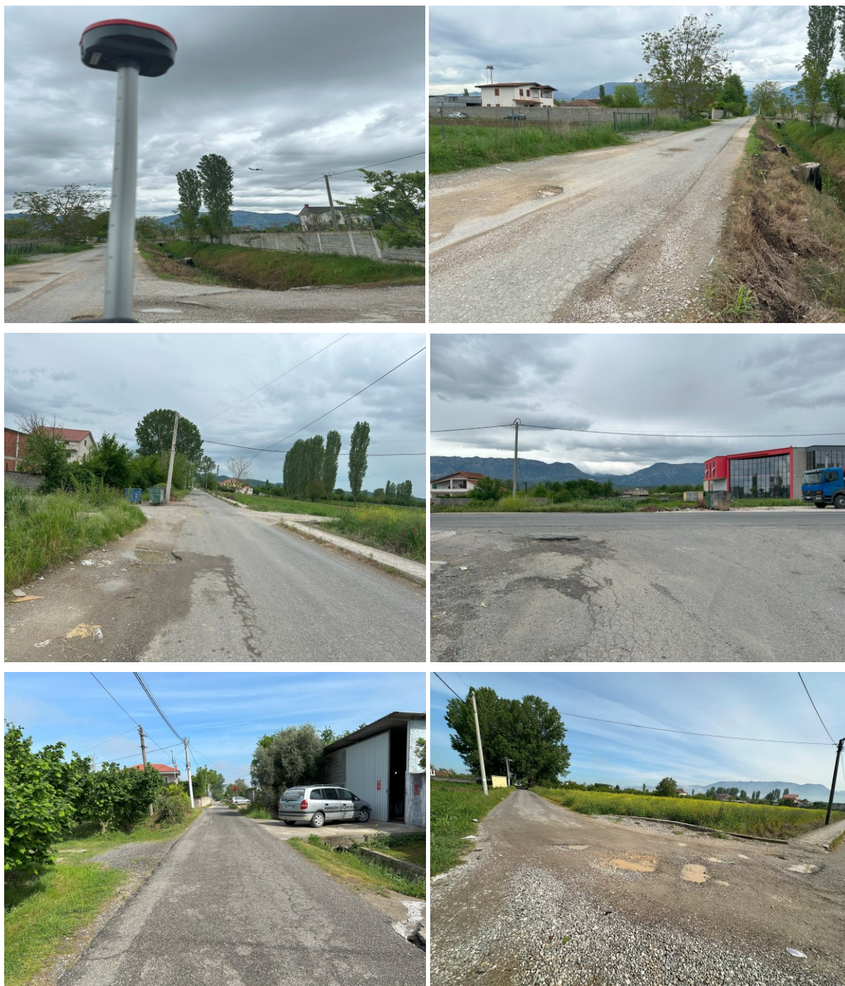
Figura 2, Foto të objektit në gjëndjen ekzistuese
