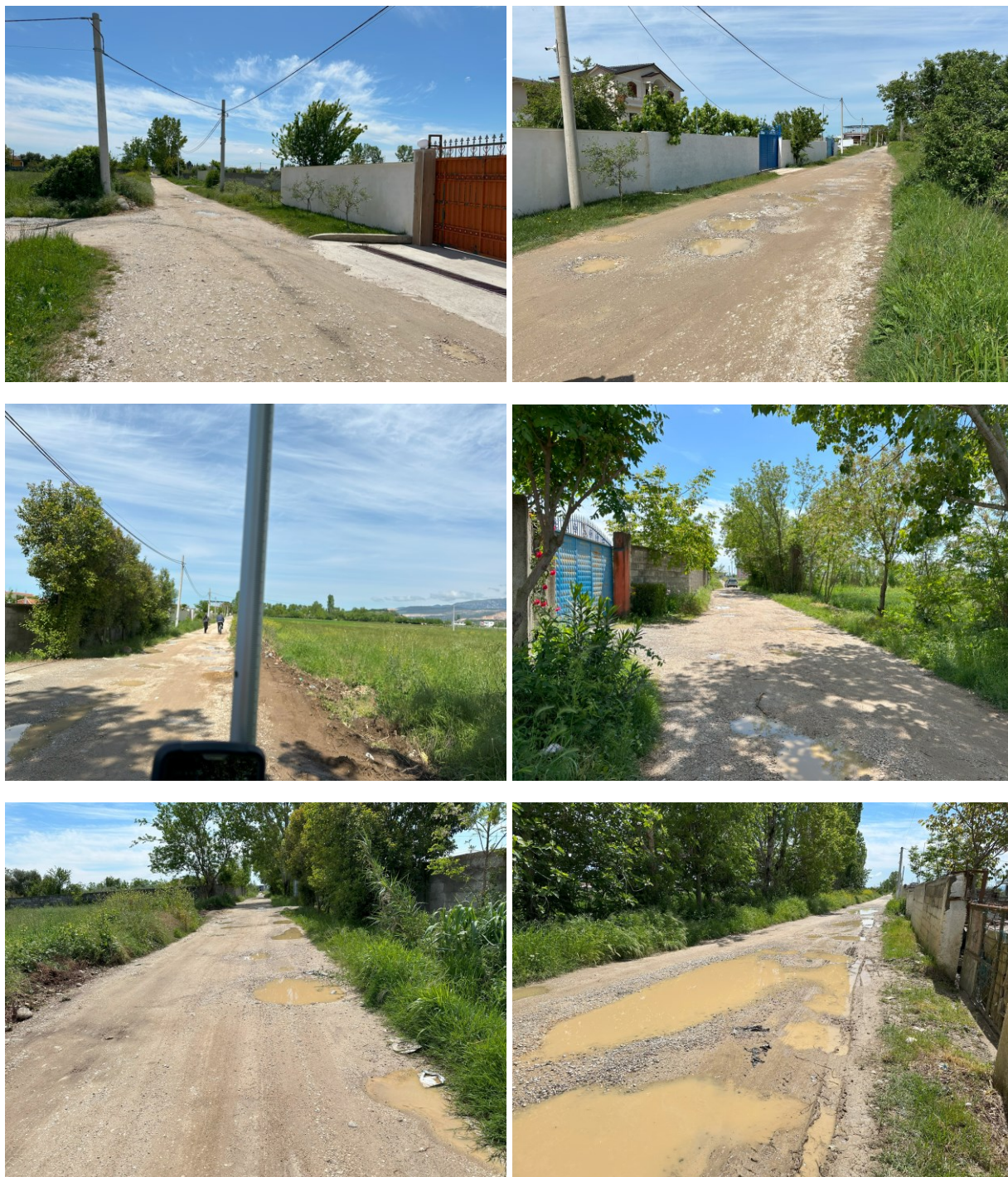
Figura 2, Foto të rrugës në gjëndjen ekzistuese
