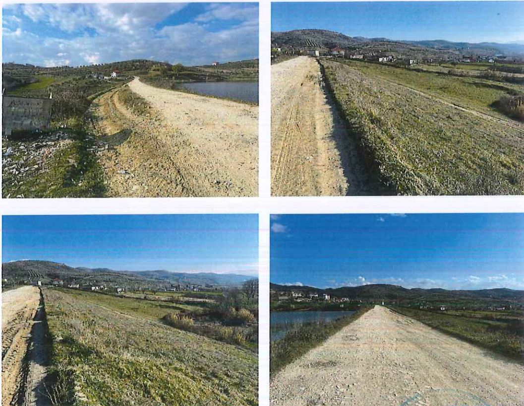
Figura 2-3 Foto te humbjes se qendrueshmerise se skarpates ne kuroren e diges
