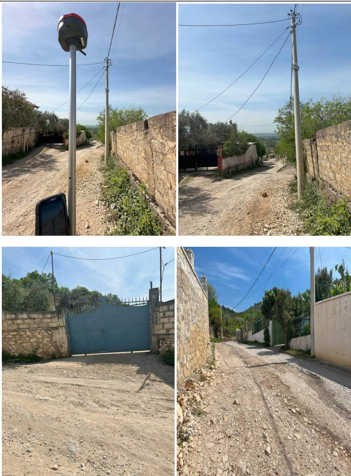
Figura 2, Foto të objektit në gjëndjen ekzistuese
