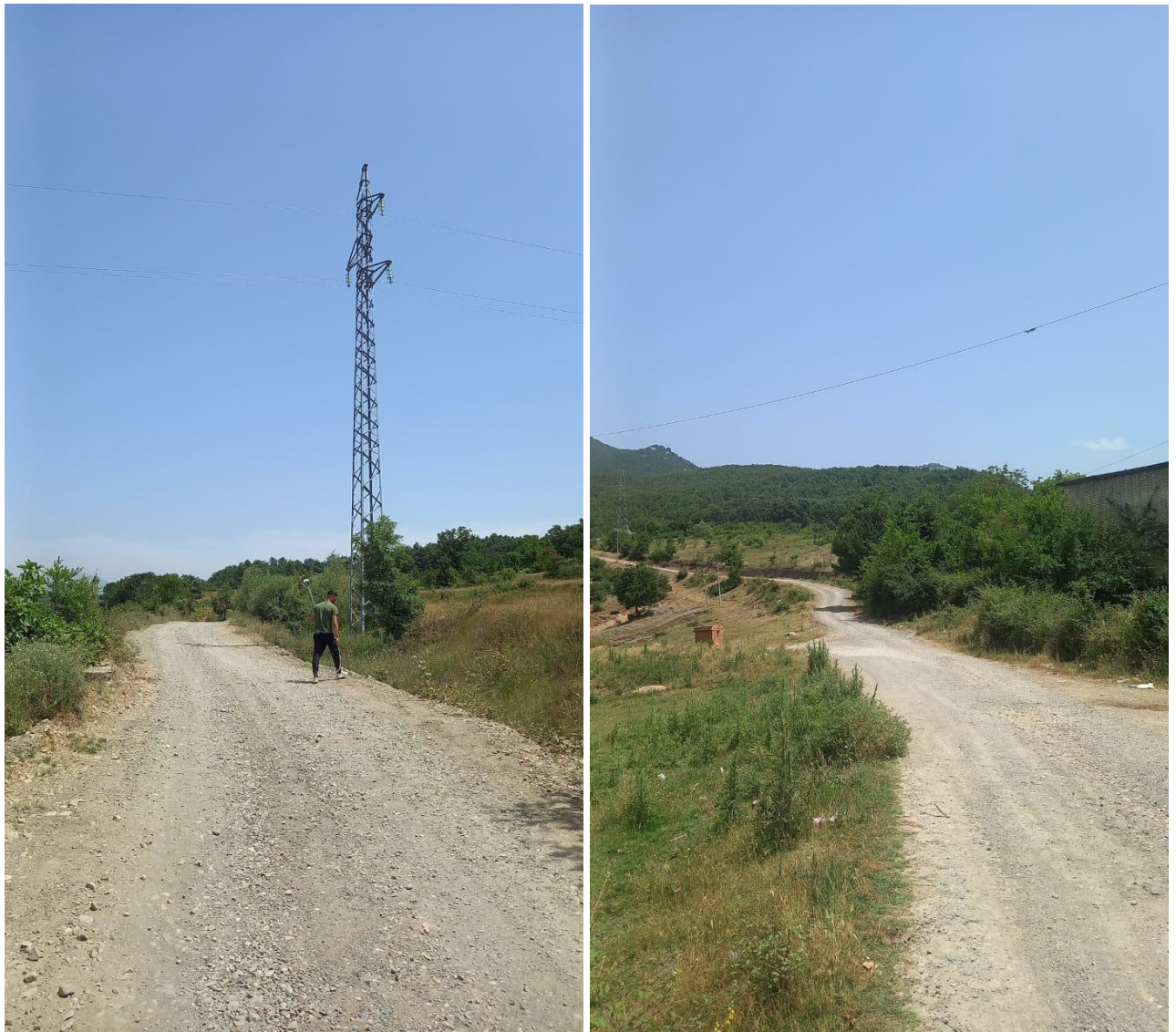
Fig.4 Gjendja ekzistuese. e rrugeve te objektit
