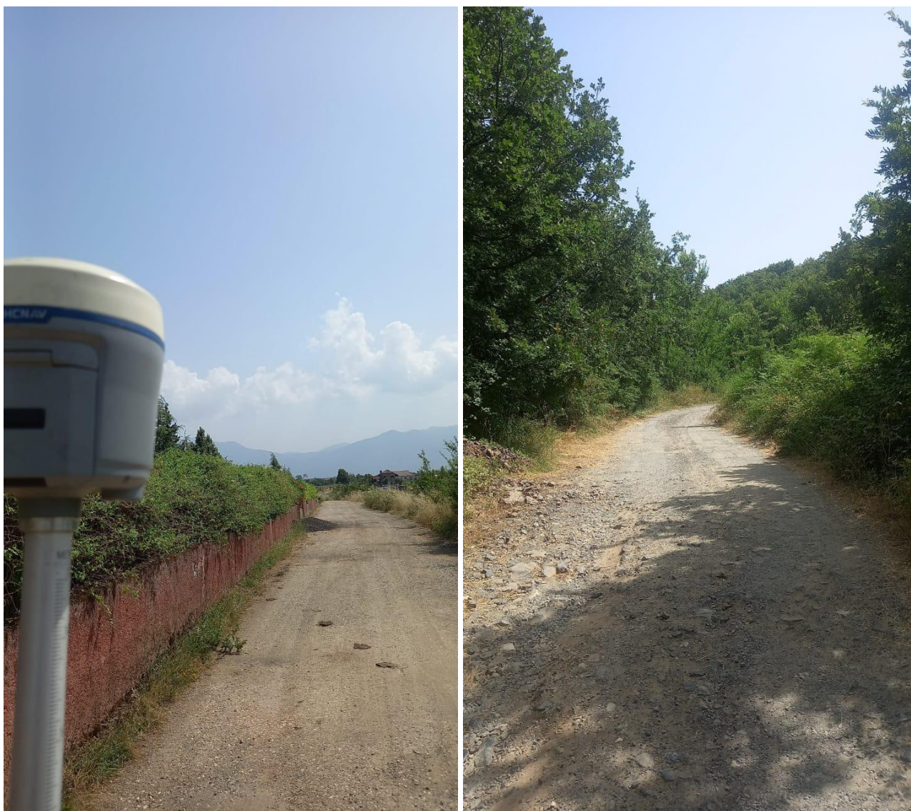
Fig.12 Gjendja ekzistuese. e rrugeve te objektit
