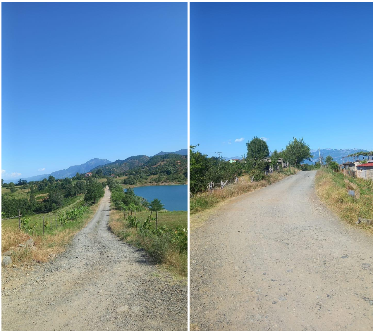
Fig.16 Gjendja ekzistuese. e rrugeve te objektit
