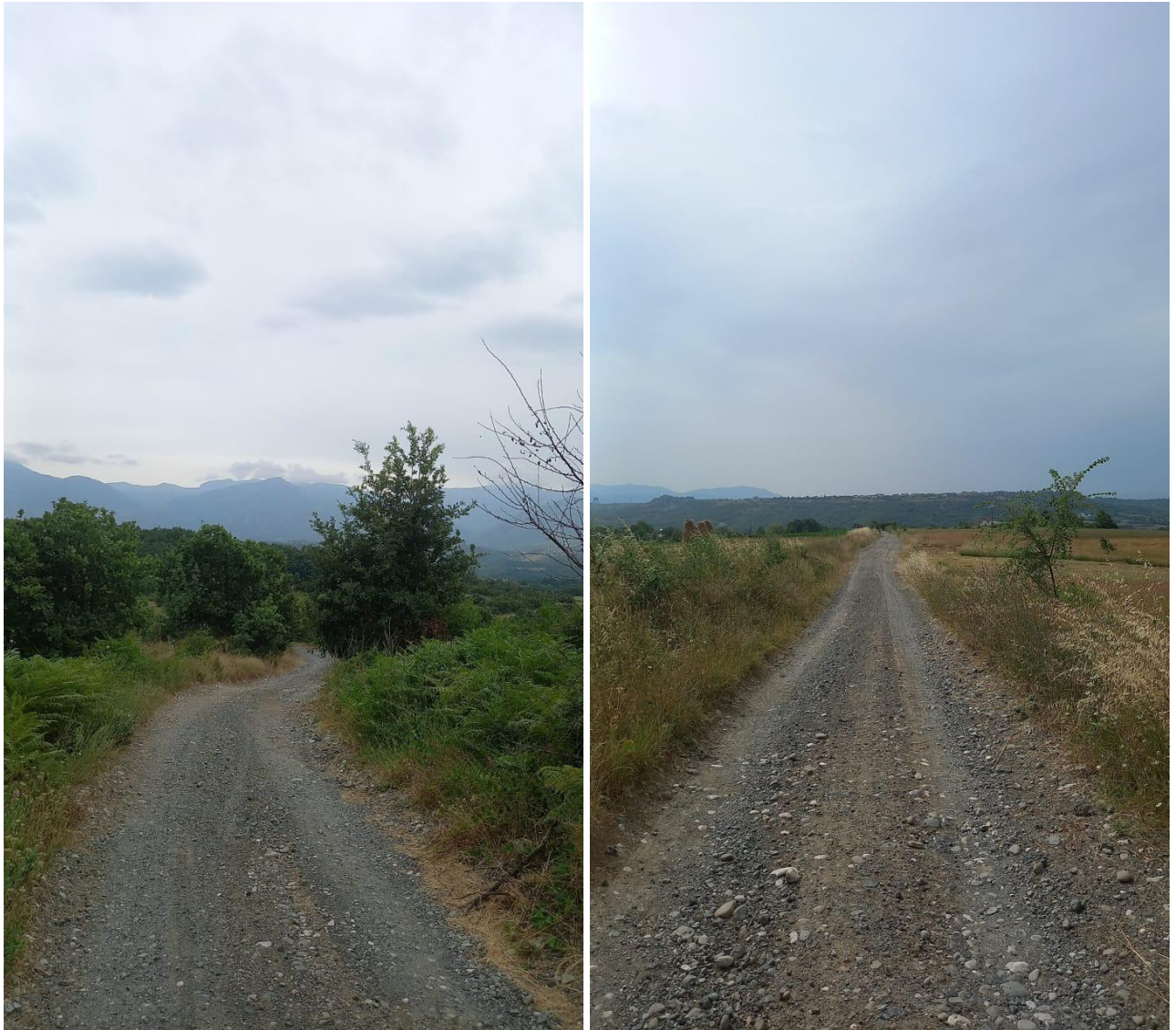
Fig.9 Gjendja ekzistuese. e rrugeve te objektit
