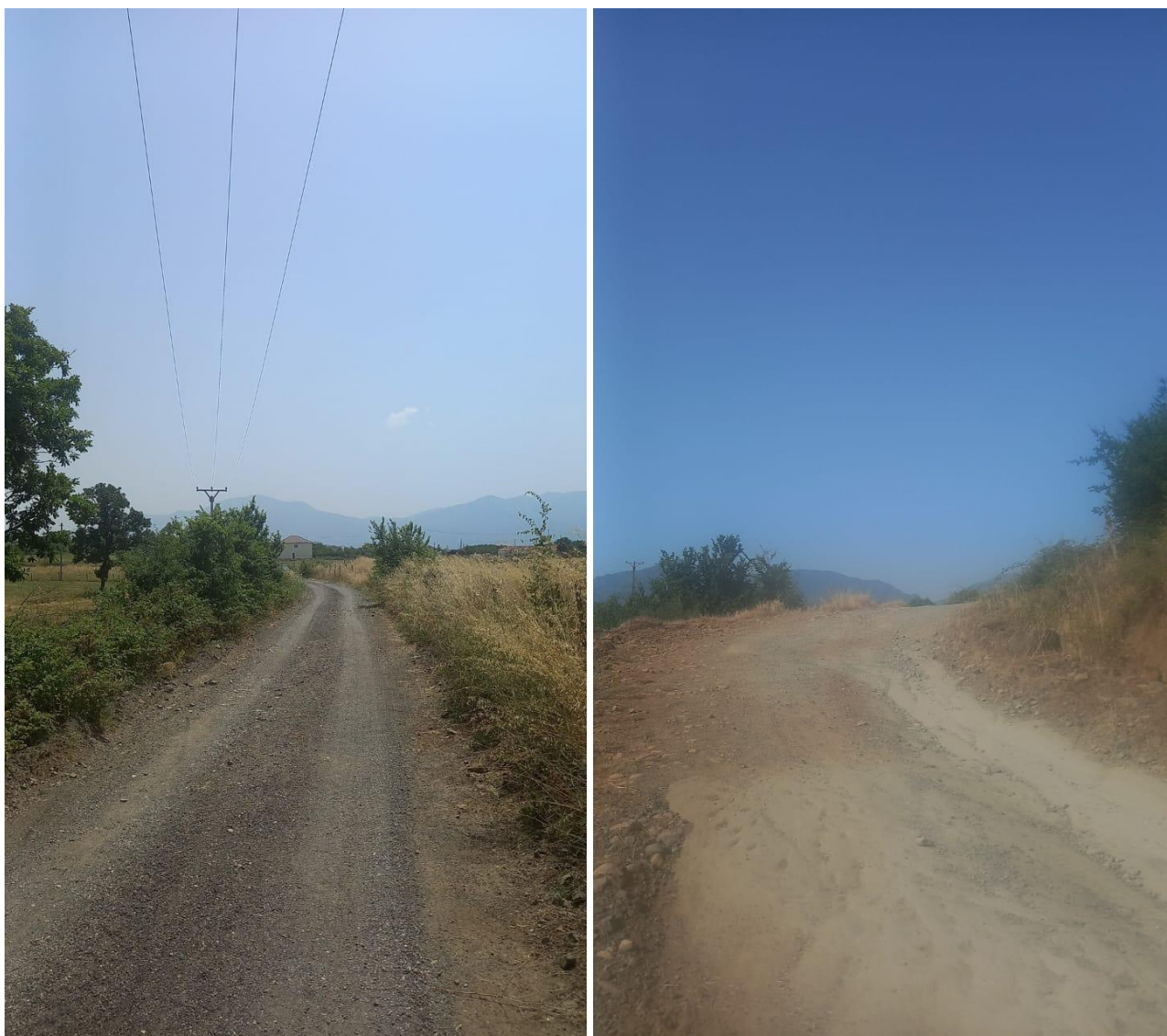
Fig.13 Gjendja ekzistuese. e rrugeve te objektit
