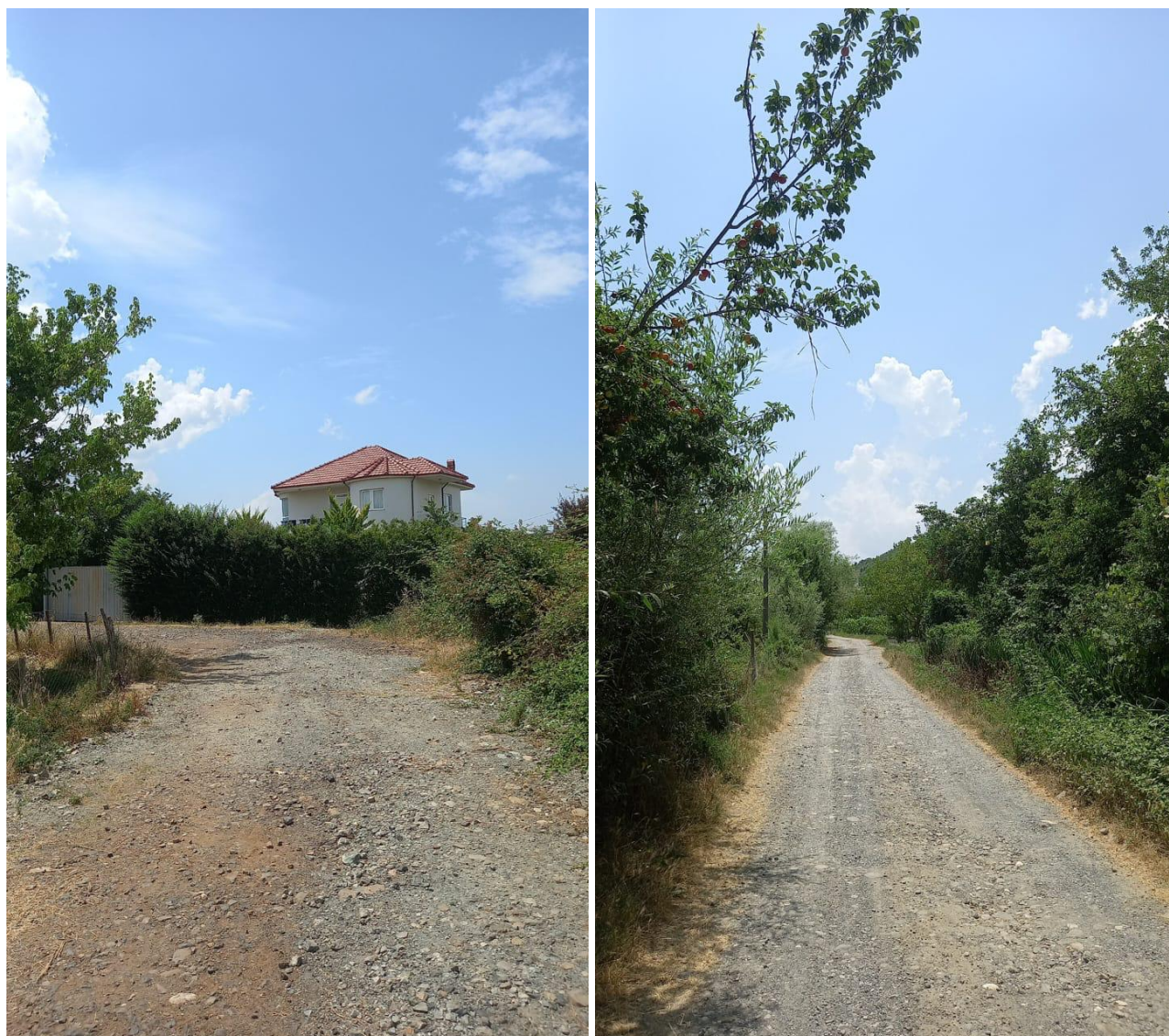
Fig.10 Gjendja ekzistuese. e rrugeve te objektit
