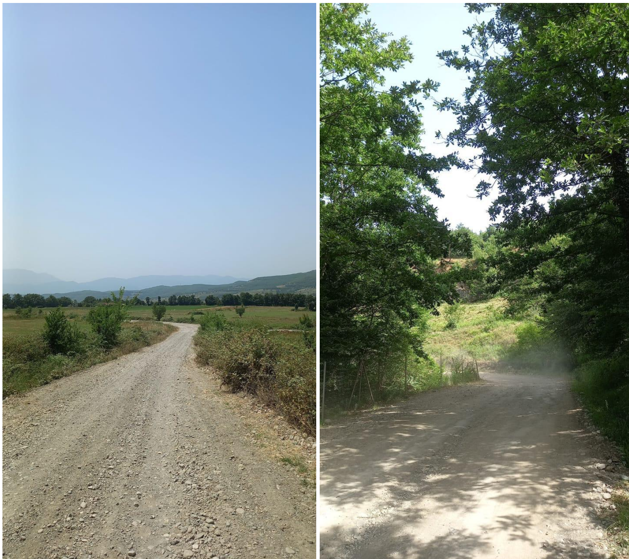
Fig.5 Gjendja ekzistuese. e rrugeve te objektit
