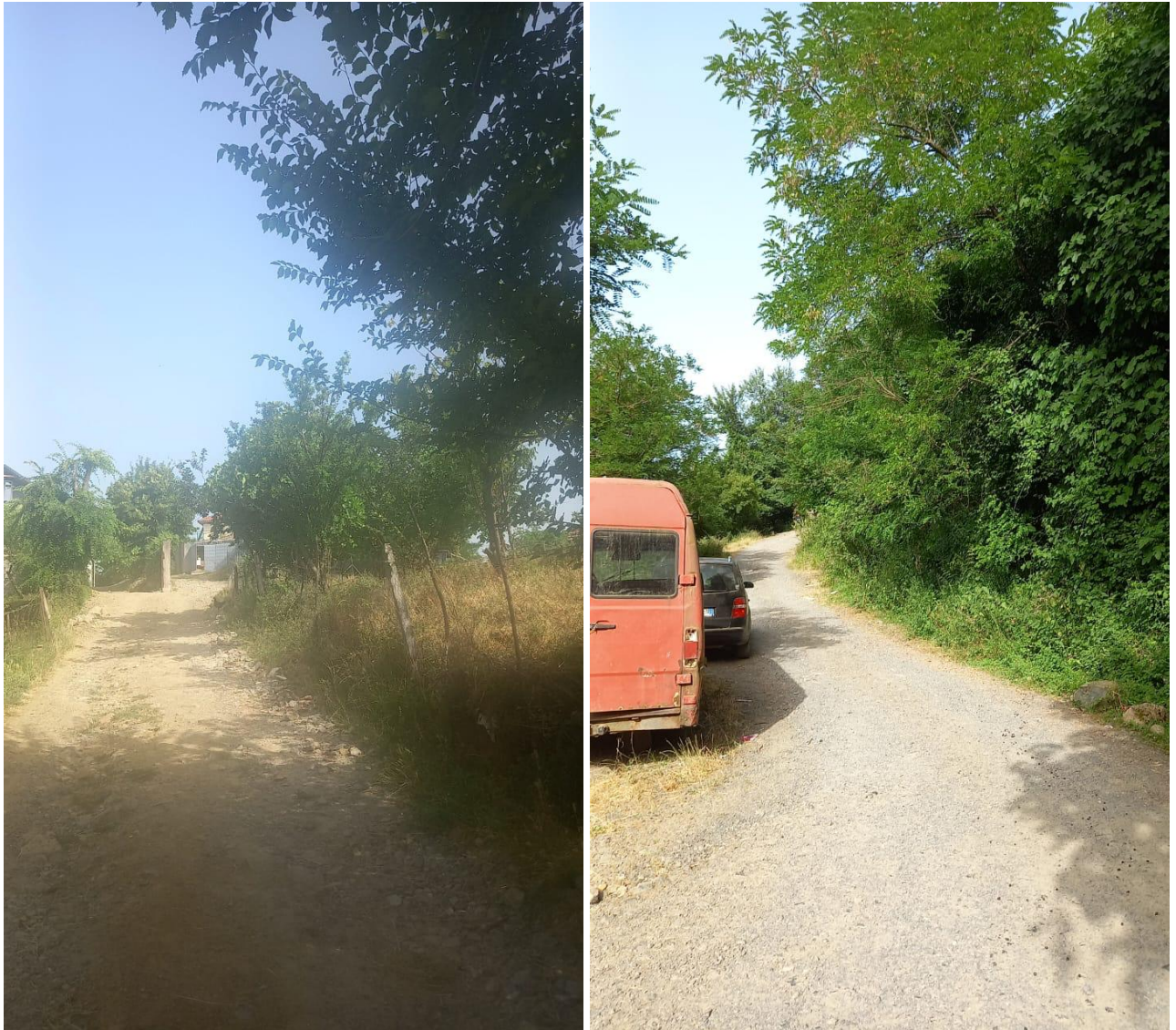
Fig.14 Gjendja ekzistuese. e rrugeve te objektit
