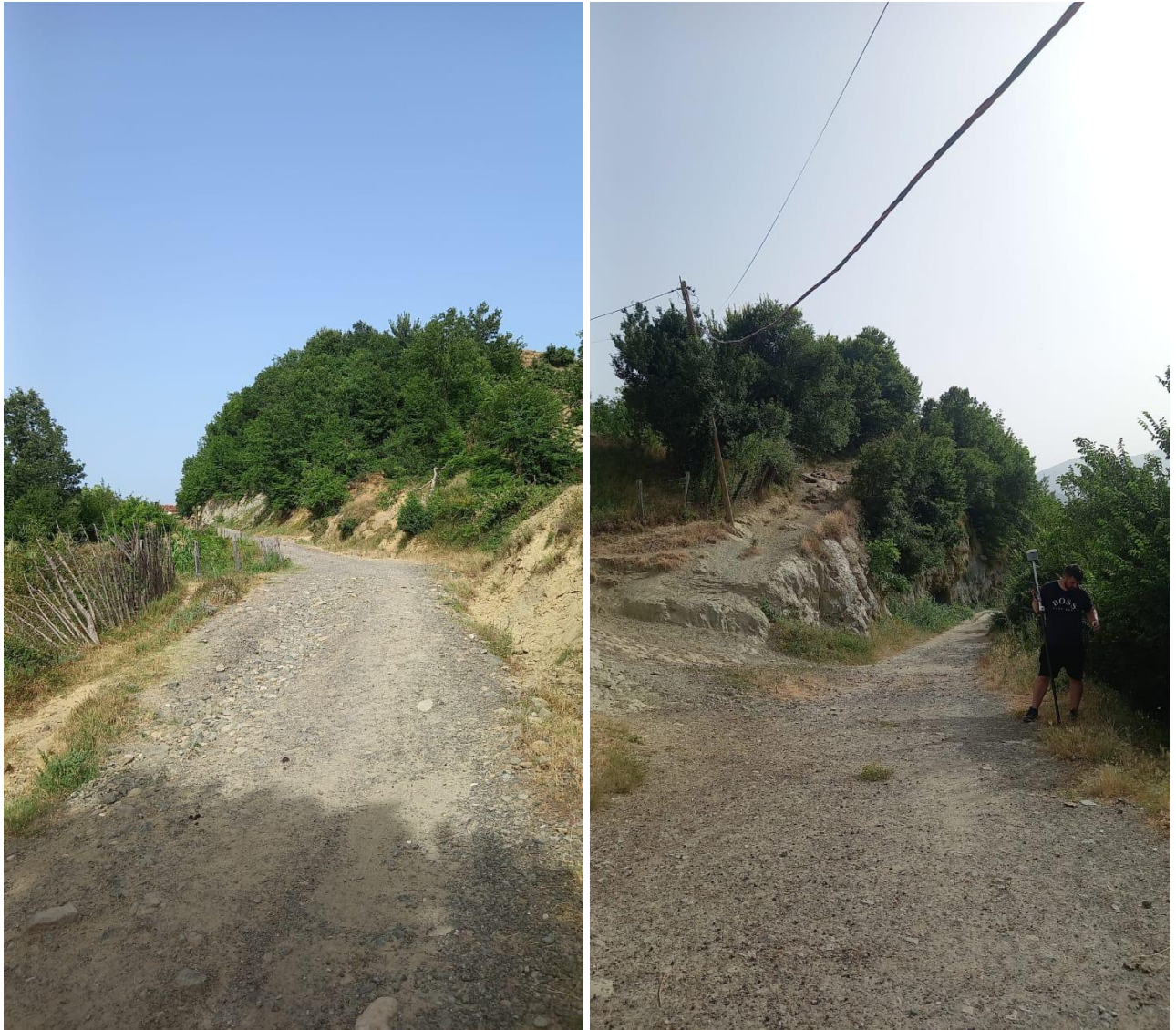
Fig.15 Gjendja ekzistuese. e rrugeve te objektit
