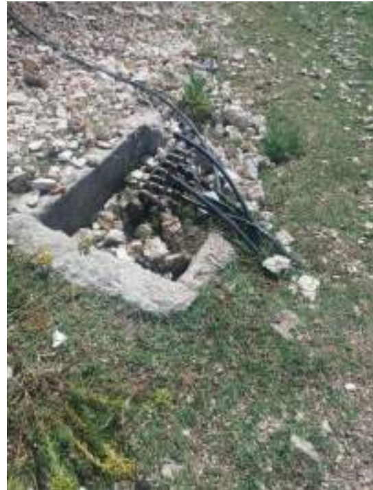
Figure 4-12: Pusetat Tip e Insalimit ne grup te Linjave te Shperndarjes Kolonje
