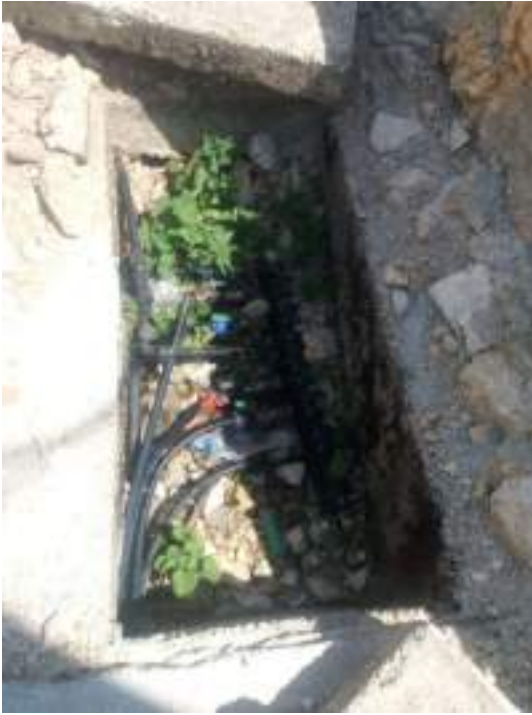
Figure 4-13: Pusetat Tip e Insalimit ne grup te Linjave te Shperndarjes Kolonje
