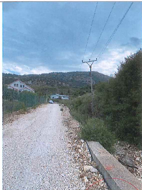
Gjendja ekzistuese e perroit ne drjetim ne bieft te siperm
