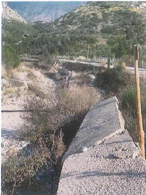
Murri mbajtes ne krahun e majte te perroit, nga progresiva 0+560 deri ne afersi te derdhjes ne det eshte i shembur.
