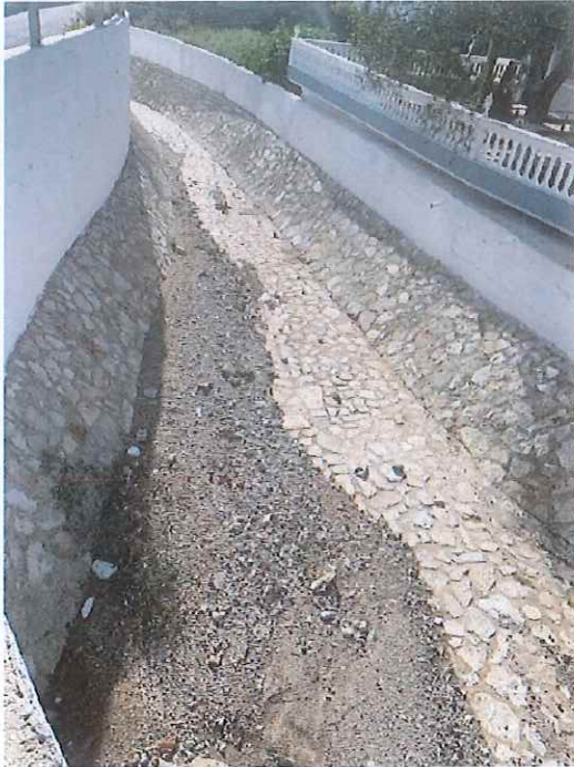
Perroi i sistemuar nga progresiva 0+380 ne drejtim te detit progresiva 0+000.
