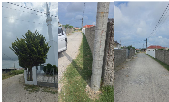
Fig 4, 5, 6: Foto të gjendjes ekzistuese
