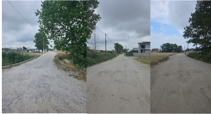
Fig 7, 8, 9: Foto të gjendjes ekzistuese
