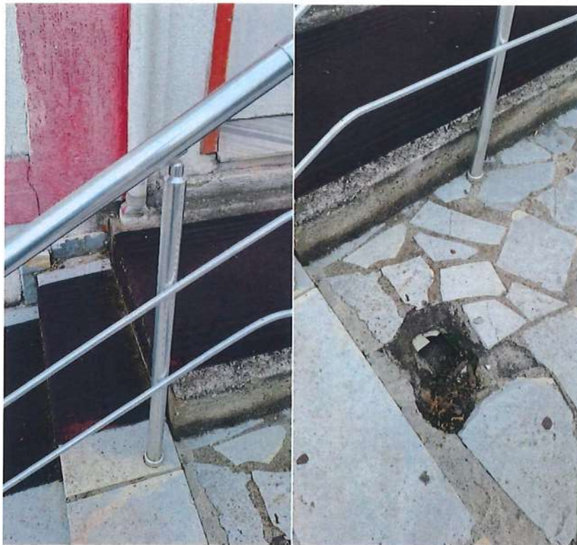
Figure 11 - Ulluku vertikal i dëmtuar
