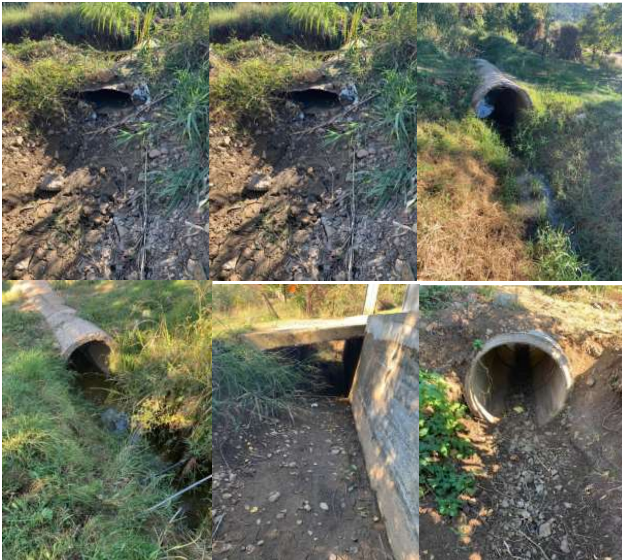
Foto ( gjendja ekzistuese )KU. Gurakuqit
