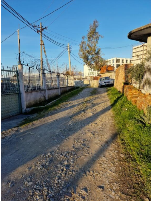
- Rruga JUSUF GERVALLA Linja 13 L=132m PE D=160mm rruga eshte e shtruar me çakull FOTO
