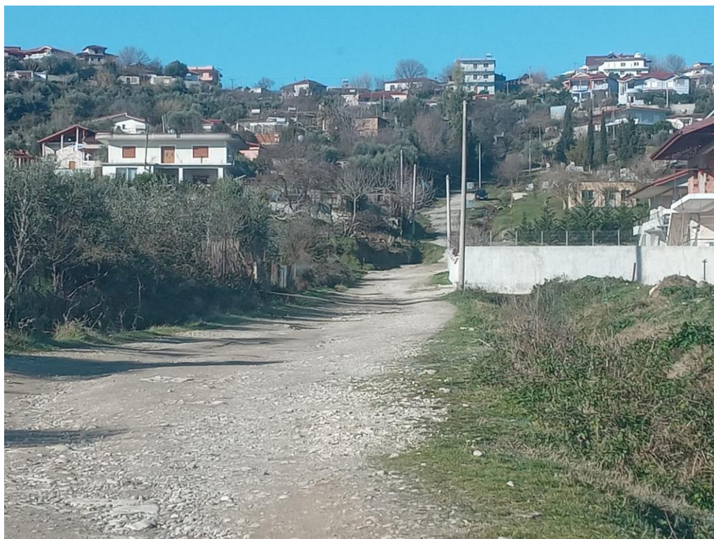
Foto te gjendjes ekzistues
