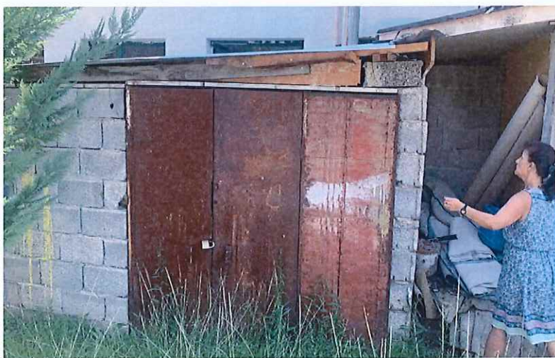
Foto te gjendjes ekzistuese
