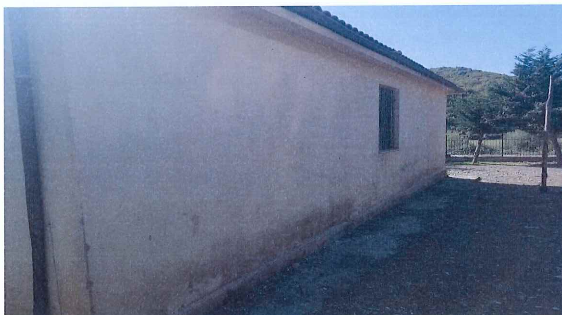
Foto te gjendjes ekzistuese te fasades
