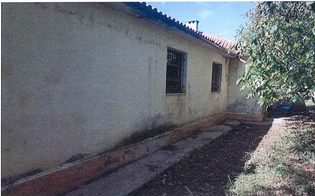
Foto te gjendjes ekzistuese te fasades
