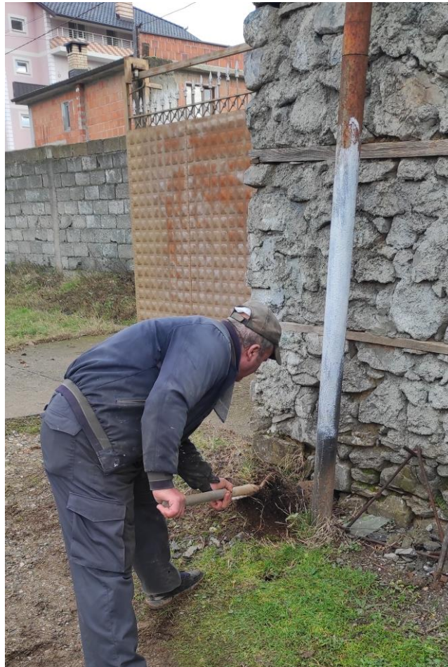
Foto pune per zbulimin e nje pusete ujematesi ne fshatin Burim
