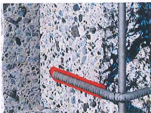
DETAJ I RIPARIMEVE TE MUREVE TE DEMTUARA
