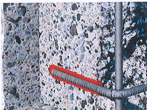
DETAJ I RIPARIMEVE TE MUREVE TE DENTUARA
