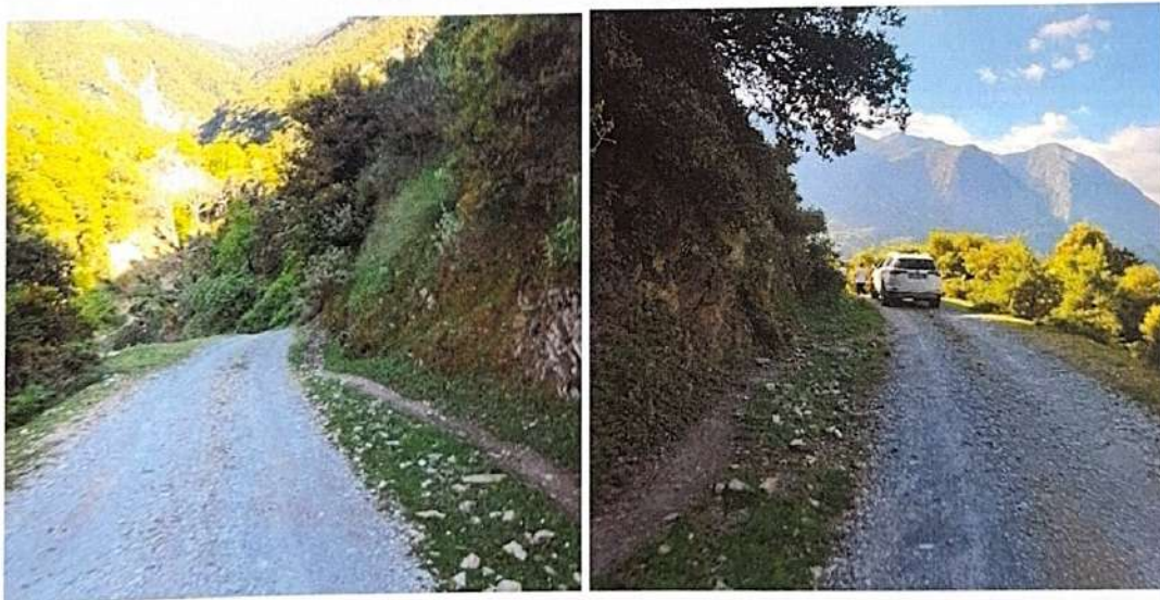
Foto të gjendjes ekzistuese
