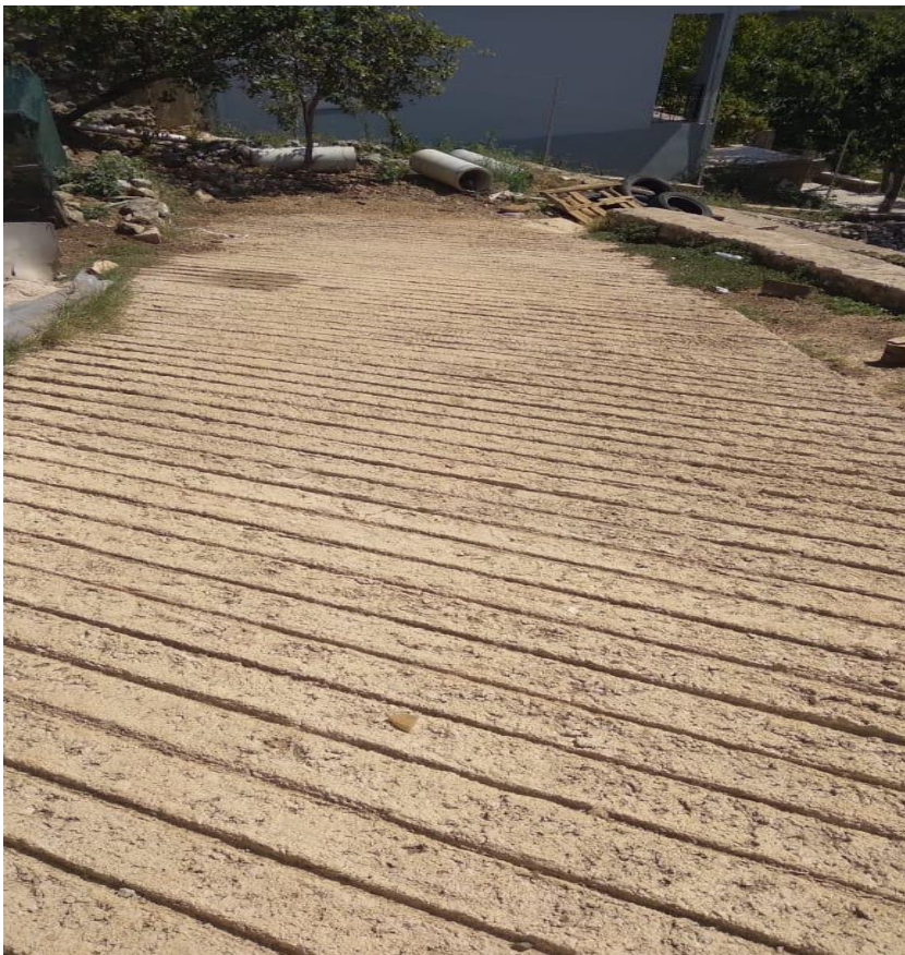
FOTO MODEL E BETONIT PAS HEDHJES DHE SISTEMIMIT.
