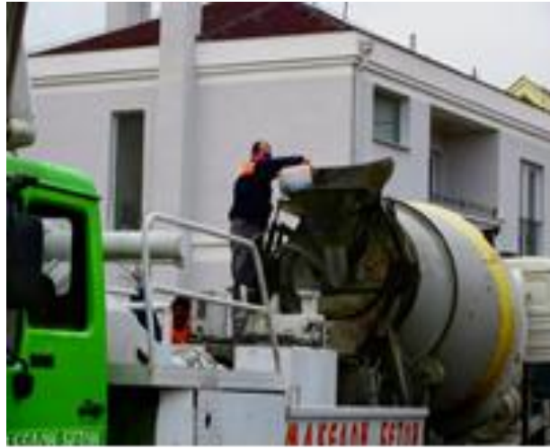
Fig. Procesi i hedhjes se betonit me betoniere
