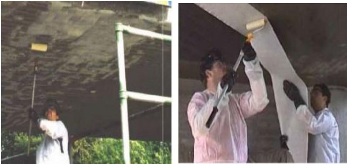
Pamje nga procesi i instalimit te fibrave te karbonit CFRP
