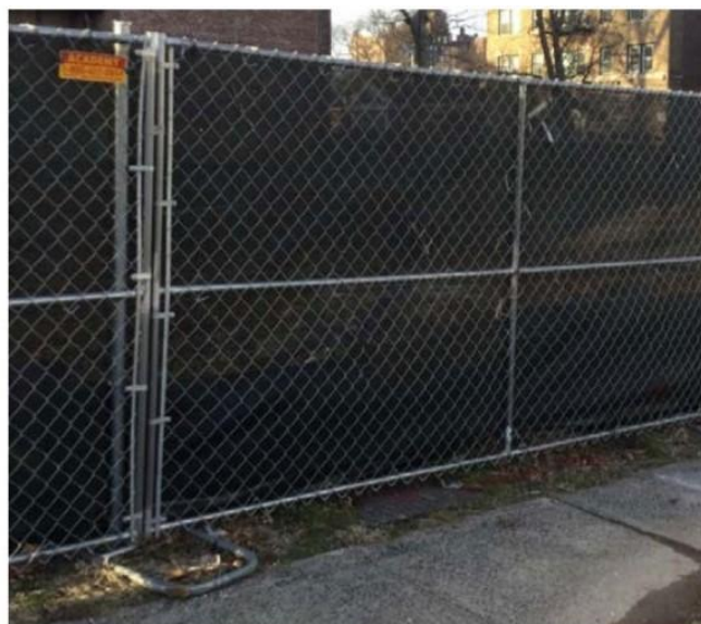
- Shembull i rrethimit të kantierit me panele sandwich ose rrjete metalike
