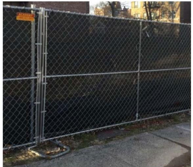
- Shembull i rrethimit të kantierit me panele sandwich ose rrjete metalike
