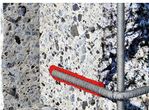
DETAJ I RIPARIMEVE TE MUREVE TE DENTUARA
